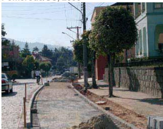
Figura 3 – Ciclovía separadora do tráfego motorizado por meio fio, em obras – Pomerode/SC, 2006
